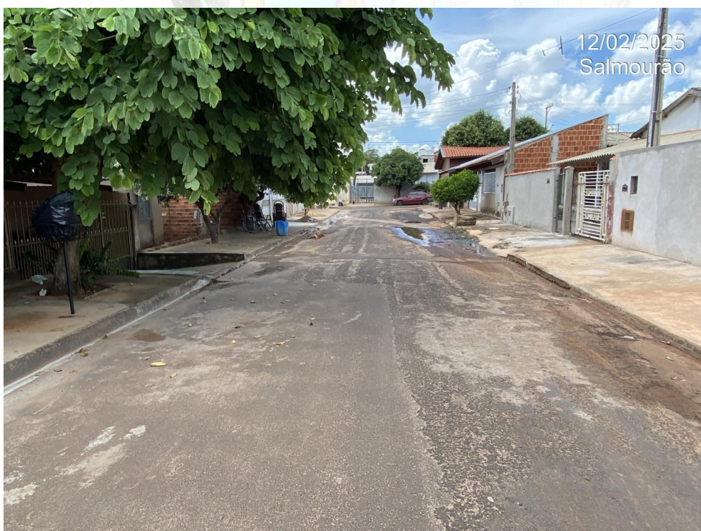
Foto 09. TRECHO DA RUA MARCILIO FREGOLENTE , entre o local indicado em projeto e a Rua Herculano da Costa Silva (pavimentação)
