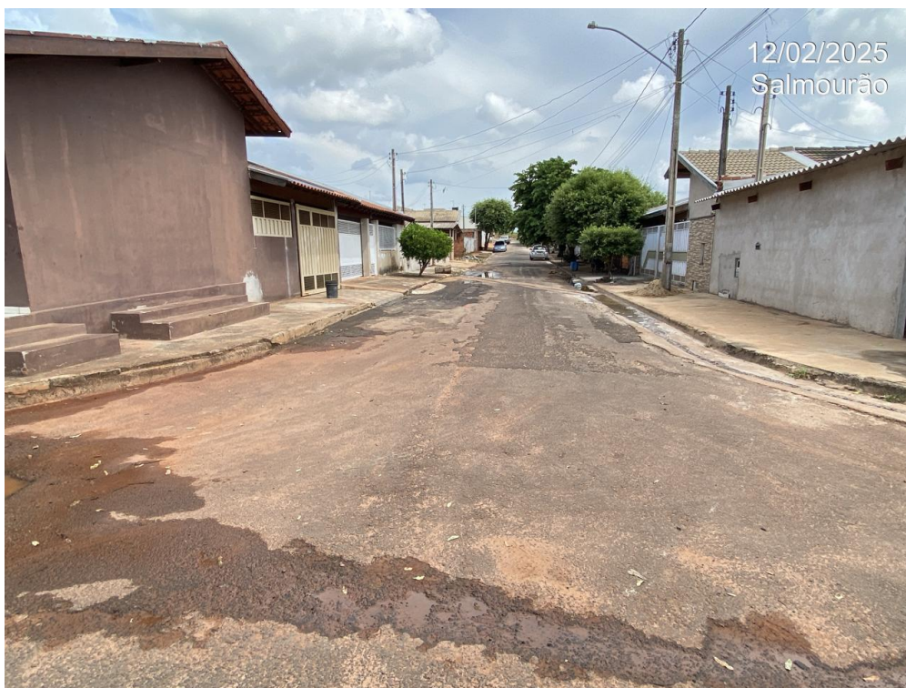
Foto 10. TRECHO DA RUA MARCILIO FREGOLENTE , entre a Rua Herculano da Costa Silva e o local indicado em projeto
