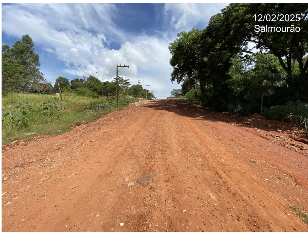
Foto 08. AVENIDA CASTELO BRANCO , drenagem urbana (sarjetão, boca de lobo, tubulação de concreto e saída de bueiro)
