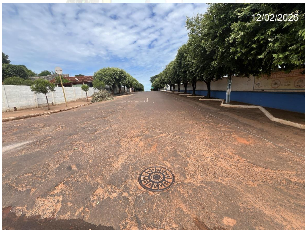
Foto 01. RUA ANDRELAINE PRAVATO , entre a Avenida Santos Dumont e a Rua Antônio Braz Xavier (recapeamento e sarjetão)
