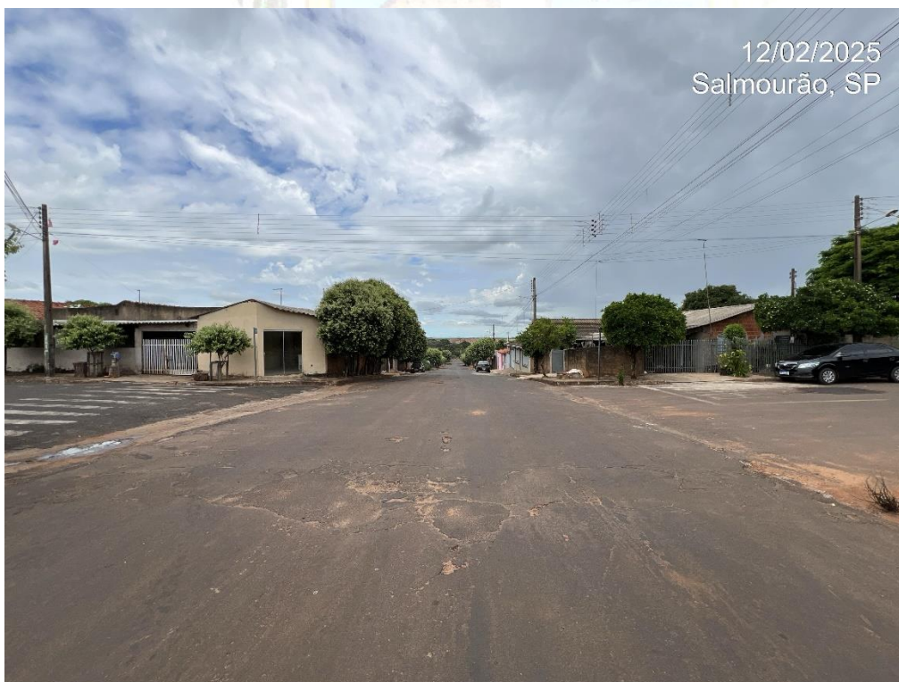
Foto 03. RUA ANTÔNIO XAVIER DA SILVA , entre a Rua João Manoel Clara e a Rua José Fernandes Costa (recapeamento)
