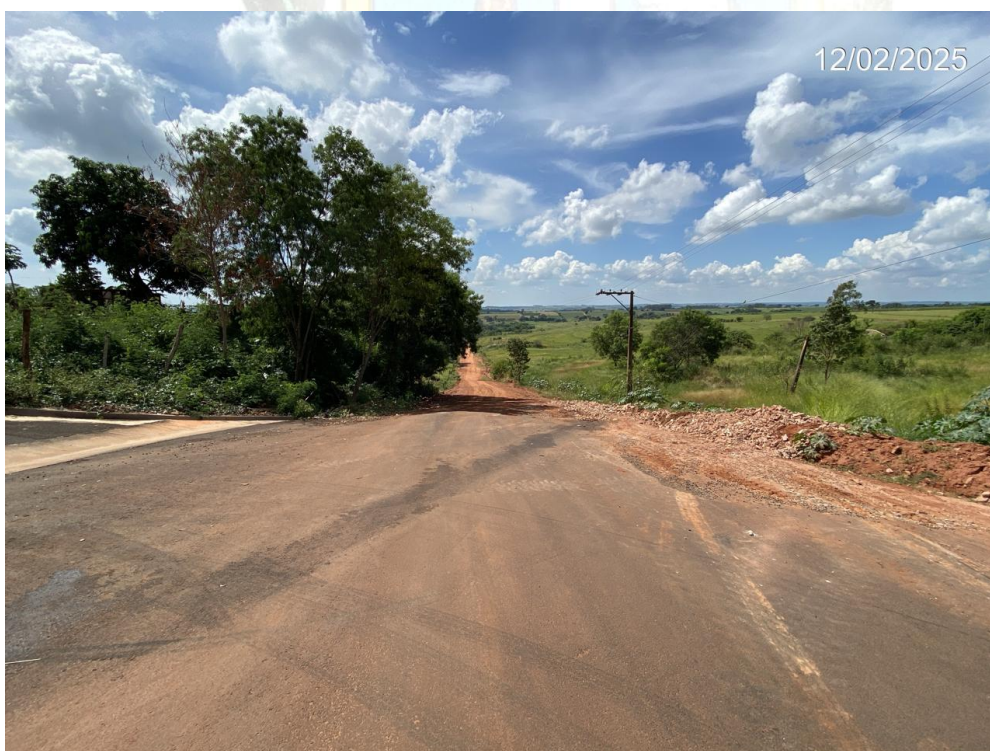
Foto 07. AVENIDA CASTELO BRANCO , drenagem urbana (sarjetão, boca de lobo, tubulação de concreto e saída de bueiro)
