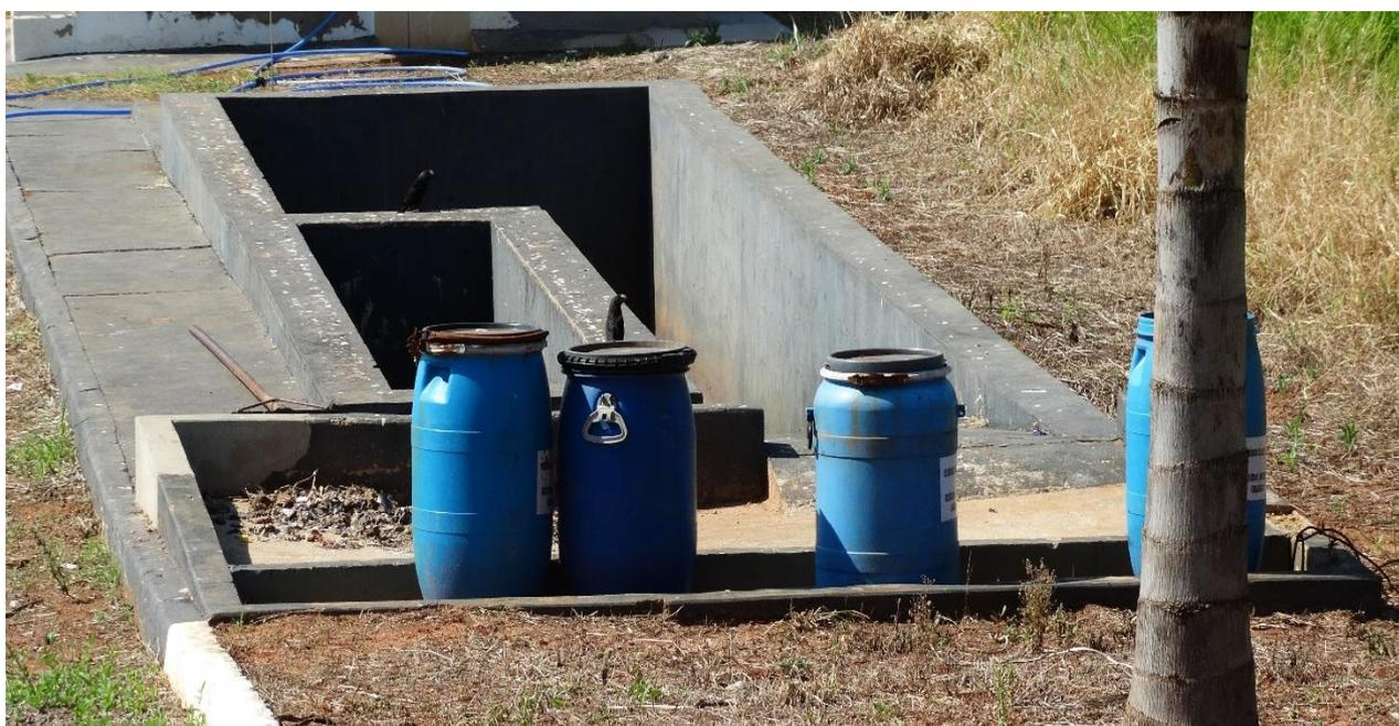
Imagem 57 – lodo originado do esgoto sendo secado e acondicionado em tambores.
